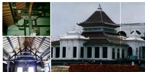
Gambar 1. Tipikal struktur rangka atap yang dipengaruhi budaya Cina.
