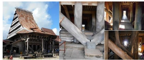
Gambar 6. Struktur bagian bawah rumah Nias di Bawomataluo, Sumatera Utara kombinasi kolom tegak yang diperkuat dengan struktur kayu bentuk V pada sumbu X dan Y.
