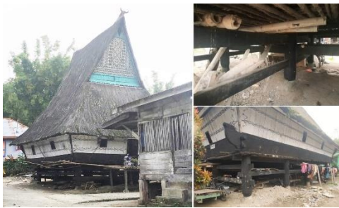
Gambar 5. Struktur bagian bawah rumah Batak Karo di desa Dokan, Sumatera Utara kolom kayu yang diperkuat dengan batang kayu yang disambung tembus, kolom di atas umpak batu.
