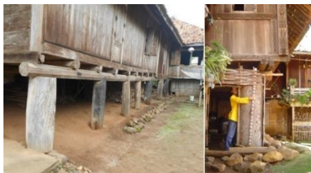
Gambar 11. Struktur bagian bawah rumah tradisional, kolom kayu utuh yang ditekakkan di atas umpak batu.
