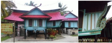
Gambar 10. Rumah Bendang di Riau memiliki bentuk balok lantai dan atap yang melengkung .
