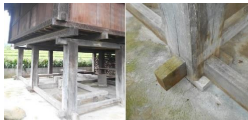
Gambar 12. Tipikal struktur tradisional rumah Pasemah, di atas batu umpak dan diperkuat dengan batang kayu yang berfungsi seperti sloof .
