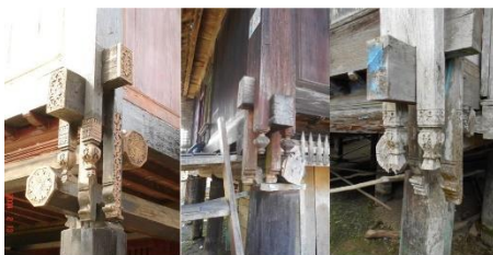
Gambar 14. Hubungan di sudut antara struktur bagian tengah dan struktur bagian bawah pada rumah Potong/Caro Ulu di Minanga.
