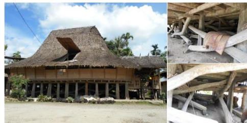
Gambar 7. Struktur bagian bawah rumah Nias di Simeasi, Sumatera Utara kombinasi kolom tegak yang diperkuat dengan struktur kayu bentuk V pada sumbu X dan Y
