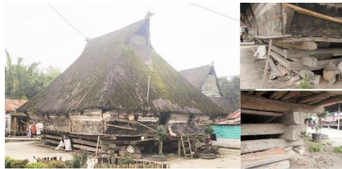
Gambar 4. Struktur bagian bawah rumah Batak karo di desa Dokan Sumatera Utara berupa tumpukan batang kayu di atas umpak batu.
