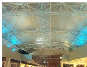
Gambar 4 Atap Membran pada Nipah Mall Makassar (Sumber : Dokumentasi Penulis, 2018)
