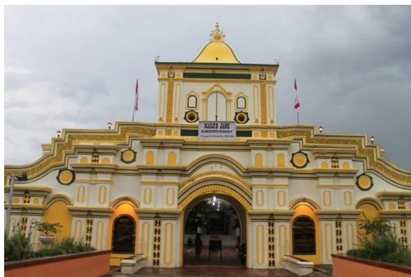
Gambar 2. Gapura sebagai akses masuk utama ke dalam komplek masjid Sumber: https://pixabay.com/en/masjid-architecture-mosque-madura-198175/
